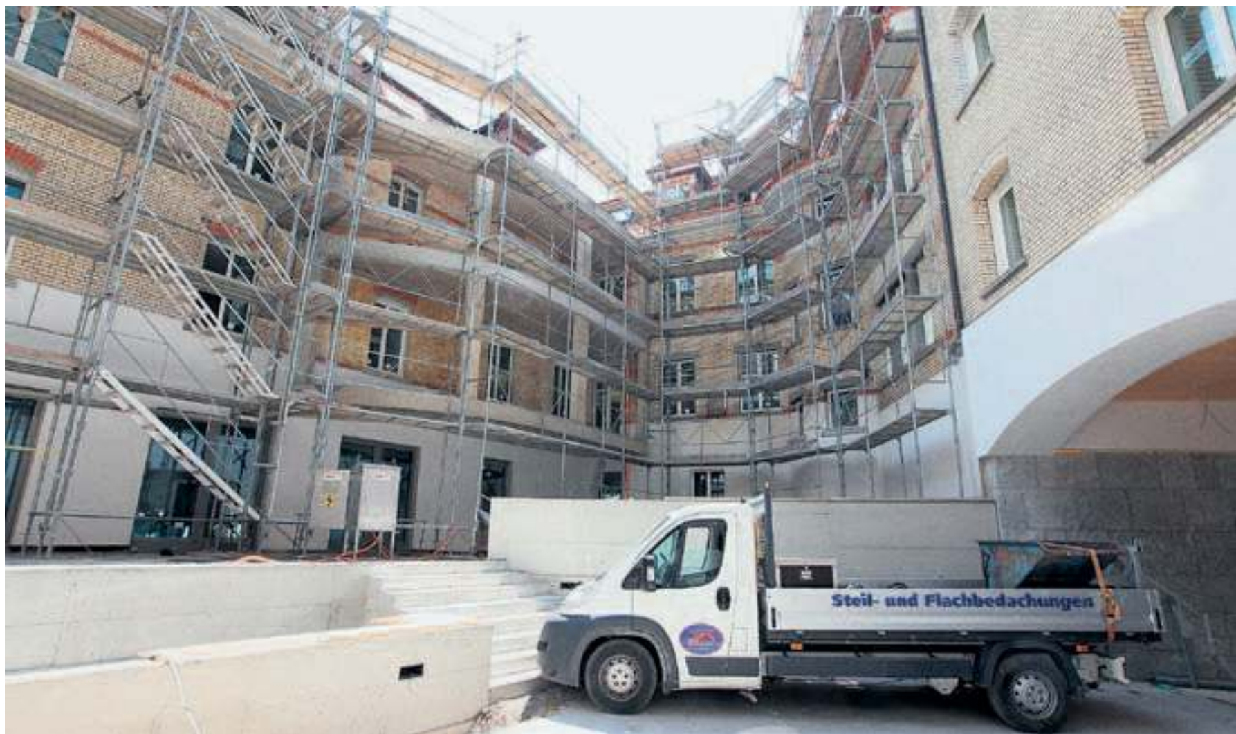
De frühere Volg-Hauptsitz an der Schaffhauserstrasse wird zu 52 Alterswohnungen umgebaut. Neue Balkone im Hof bieten Ruhe im verkehrsnah gelegenen Gebäude. Bild: David Baer
