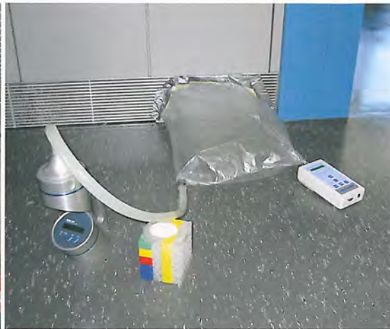
Erfassung des Ausstosses der Lüftung: Diese ist für ein gutes Innenraumklima entscheidend.
